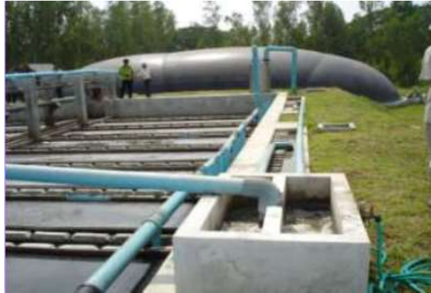
ภาพที่ 3.2 บ่อหมักแบบ H-UASB
