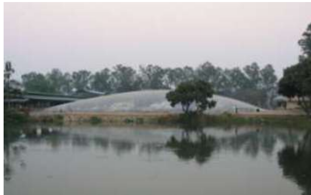
ภาพที่ 3.5 บ่อหมักแบบ Covered Lagoon
