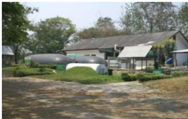
ภาพที่ 3.3 บ่อหมักแบบราง (Plug Flow digester)
