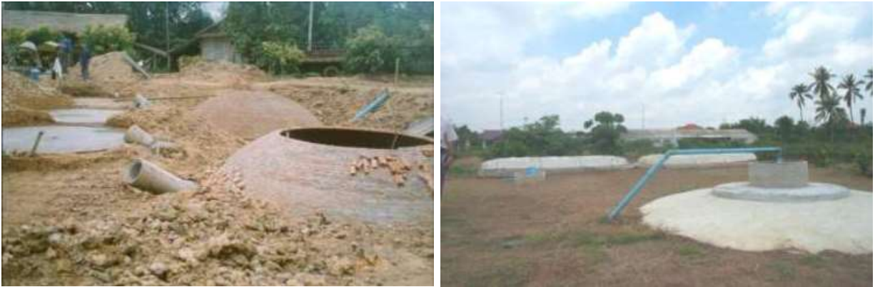
ภาพที่ 3.1 บ่อหมักแบบโดมคงที่ (Fixed dome digester)
