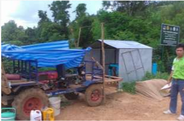
ภาพที่ 19 โครงการวางท่อส่งน้ำเพื่อการเกษตร มาตรการที่ 4 อ.ท่าลี่ จ.เลย (ศปผ.)
