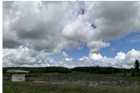
โครงสร้างพื้นฐานอ่างเก็บน้ำ พื้นที่ป่าสงวนแห่งชาติ ป่าดงหมู จังหวัดมุกดาหาร
