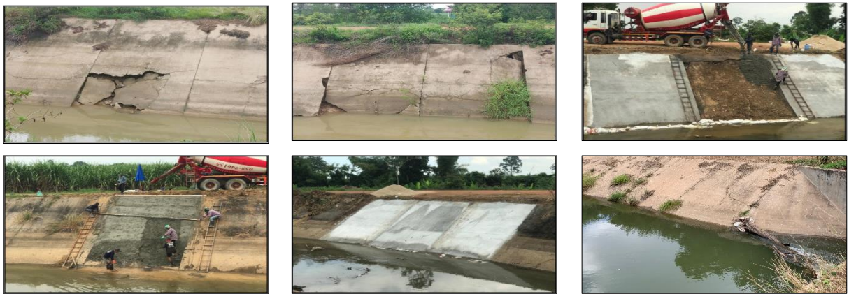
ซ่อมแซมคอนกรีตตาดคลองส่งน้ำสาย MC กม. ๑๖+๙๓๐ ถึง กม. ๑๘+๙๘๐ จังหวัดกำแพงเพชร
