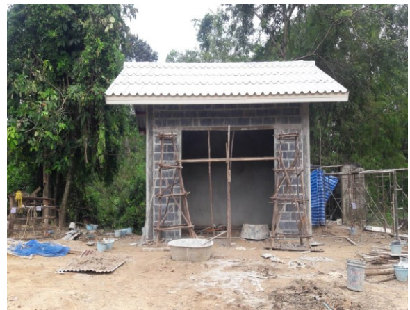
ก่อสร้างอาคารควบคุมและโรงเก็บวัสดุ
