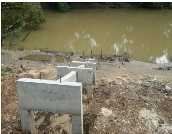
บริเวณติดตั้งสถานีสูบน้ำด้วยไฟฟ้า ด้านเหนือของฝายห้วยบังอี่
