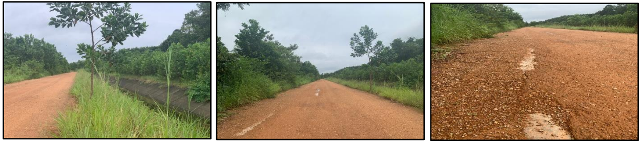
ถนนบนคันคลองส่งน้ำสายใหญ่ โครงการส่งน้ำและบำรุงรักษาคลองสี่ด จังหวัดฉะเชิงเทรา
