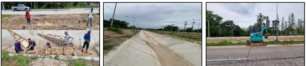
โครงการปรับปรุงคลองส่งน้ำสาย ๑R-๑L-LMC จังหวัดนครศรีธรรมราช
