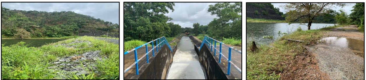
ซ่อมแซมอ่างเก็บน้ำเขาระกำและอาคารประกอบ จังหวัดตราด
