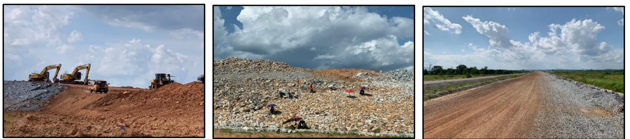
ทำนบดินหัวงานและอาคารประกอบ โครงการอ่างเก็บน้ำคลองหางแมว จังหวัดจันทบุรี
