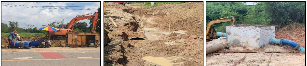
ปรับปรุงระบบส่งน้ำสถานีสูบน้ำด้วยไฟฟ้า อ่างเก็บน้ำคลองหลวงรัชโลทร-บ้านคลอง จังหวัดชลบุรี
