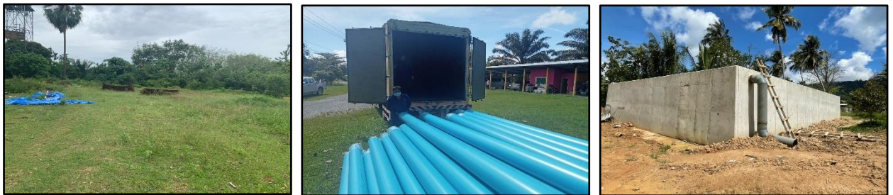
ระบบส่งน้ำอ่างเก็บน้ำทำนบ ๑ (ระยะที่ ๒) จังหวัดนครศรีธรรมราช
