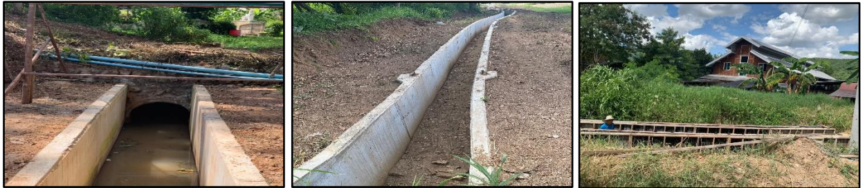
ปรับปรุงระบบส่งน้ำฝายวัดบ้านพงเหนือ พร้อมอาคารประกอบ จังหวัดเชียงใหม่
