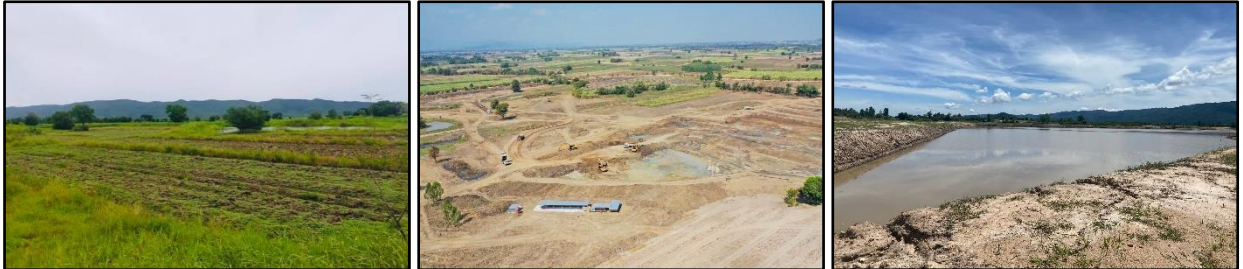
โครงการขุดลอกอ่างเก็บน้ำคลองโพธิ์ จังหวัดนครสวรรค์
