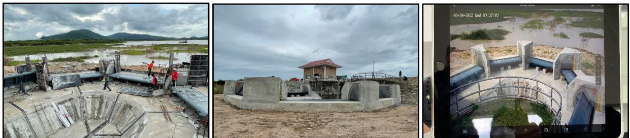
เพิ่มความจุอ่างเก็บน้ำบ้านบึงขยาย จังหวัดจันทบุรี
