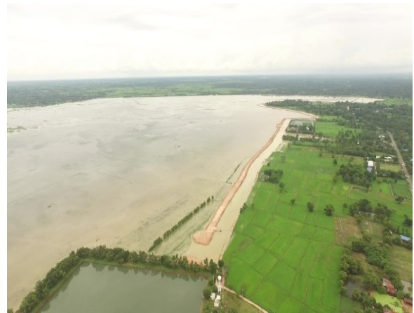
ขุดลอกกันเขตอ่างเก็บน้ำห้วยลำพอก ระยะทาง ๑๖.๘๓ กิโลเมตร กว้าง ๑๐ เมตร ลึก ๒.๕๐ เมตร
