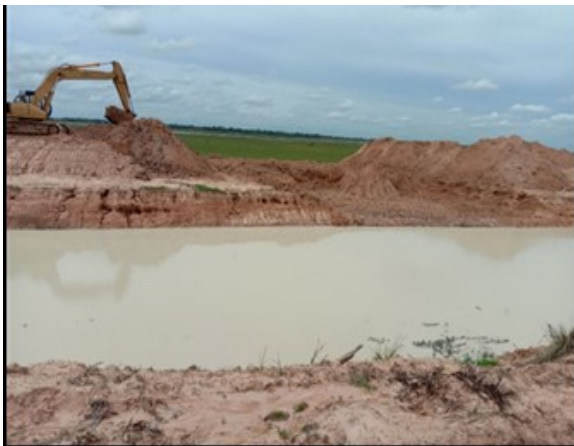
ขุดลอกกันเขตอ่างเก็บน้ำห้วยลำพอก ระยะทาง ๑๖.๘๓ กิโลเมตร กว้าง ๑๐ เมตร ลึก ๒.๕๐ เมตร
